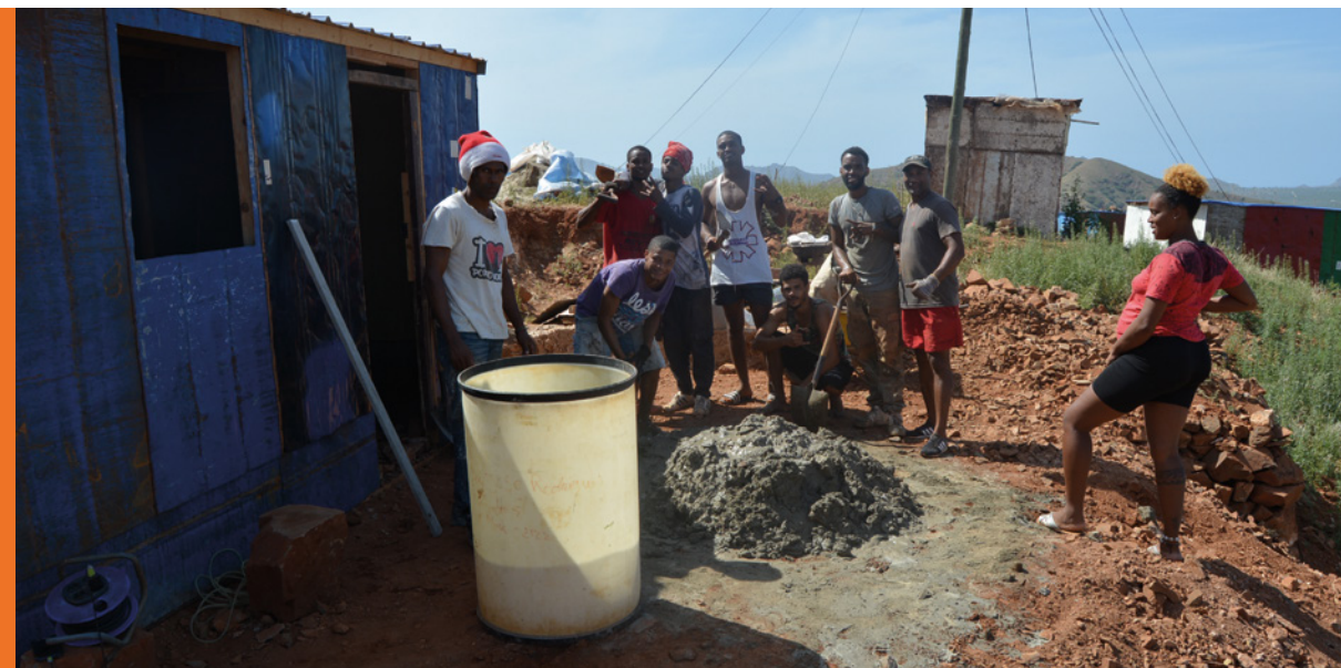
Festa de fim de obra, Francisco Craveiro, 2021.
