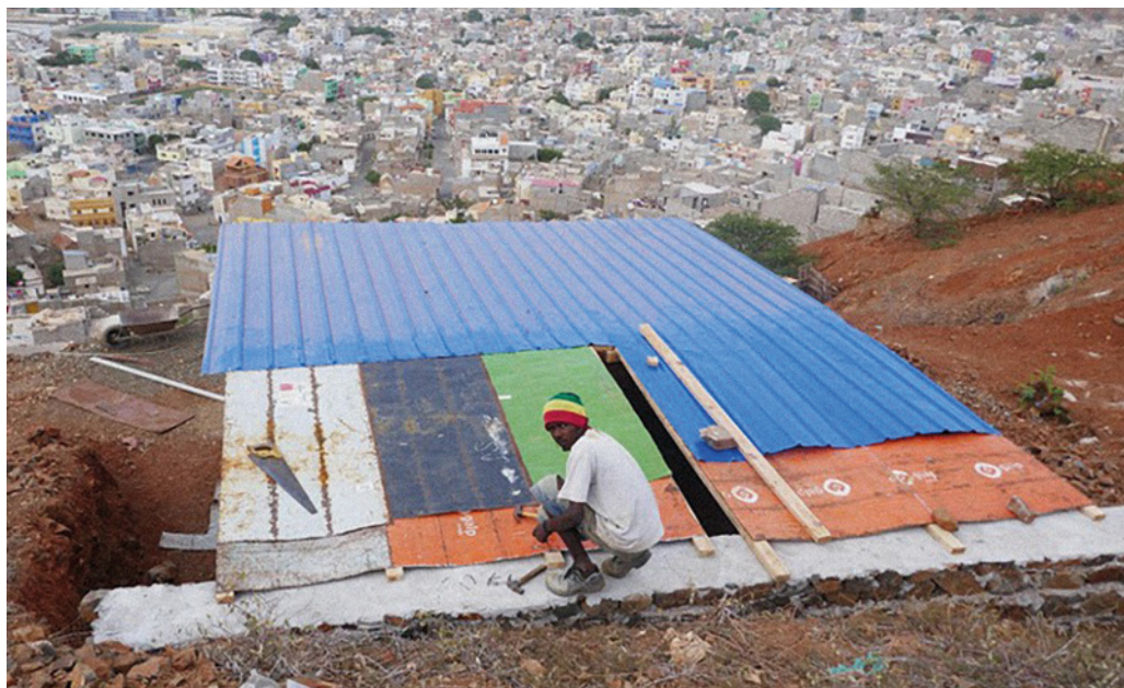
Construção de casa de tambôr no Alto de Bomba, Álvaro Domingues, 2021 / Construction of a “casa de tambôr” in Alto de Bomba, Álvaro Domingues, 2021.
