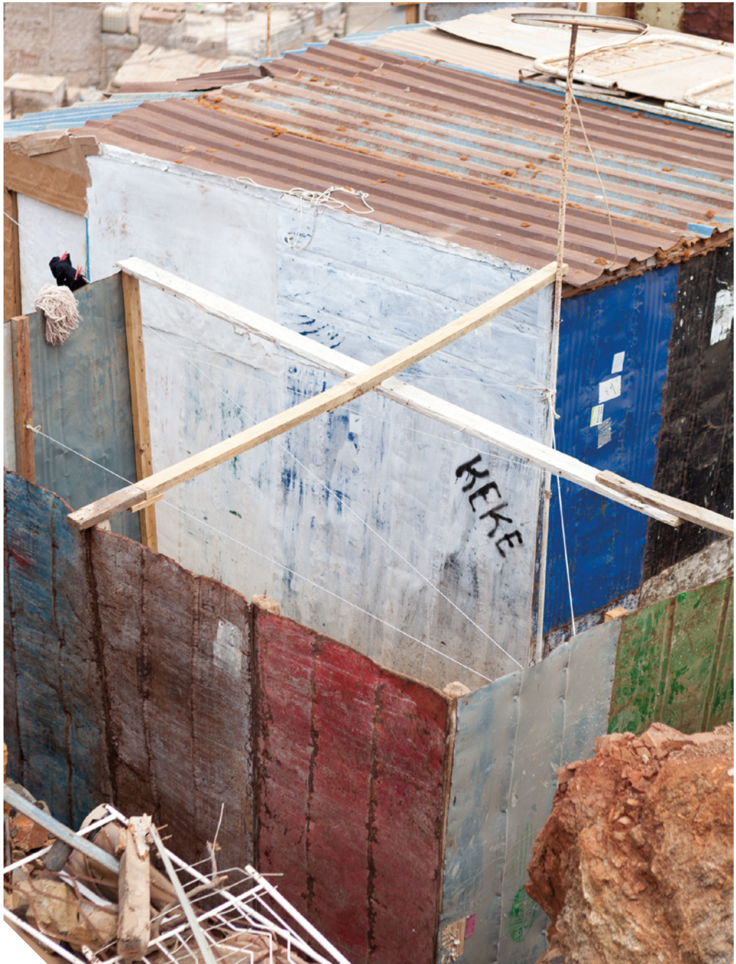
Detalhe da construção de uma casa de tambôr no Alto de Bomba, Diogo Bento, 2019.
